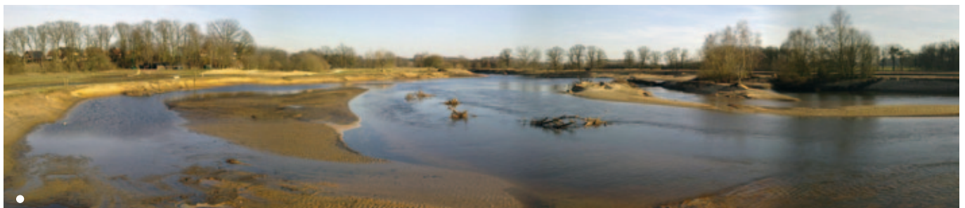
● Entfesselung und Laufverlegung der Ems bei Einen: In einem klar definierten Korridor wurde der Ems mehr Raum zur dynamischen Entwicklung gegeben. Dafür wurden die meisten Ufer entfesselt, in landwirtschaftlich sensiblen Bereichen jedoch auch Sicherungen eingebaut. (Foto: Uwe Koenzen)
