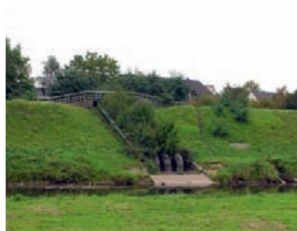
Dükeranlagen am Deich
