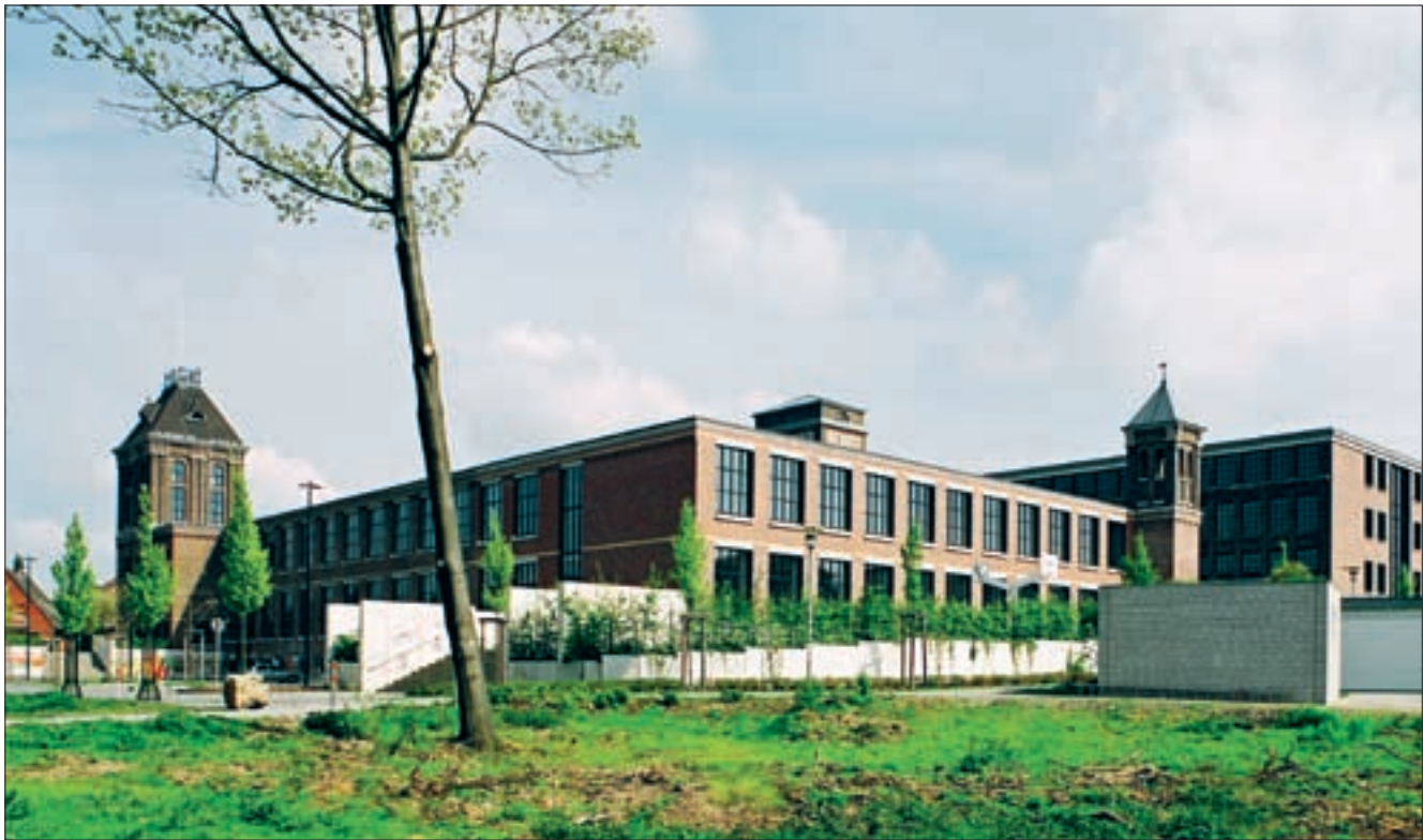
Ehemalige Textilfabrik Bendix in Dülmen, heute ein gemischtes Stadtquartier
